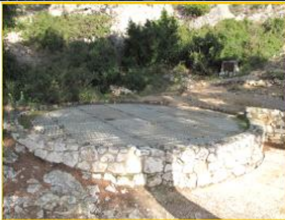
Puits de plongée des canalisations dans la calanque de PORT-MIOU
