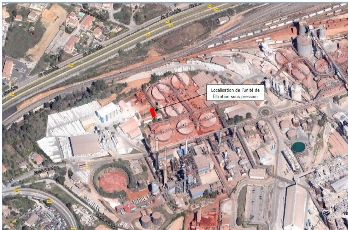
Figure 12 : Localisation de l'unité de filtration sous pression au sein de l'usine de Gardanne
